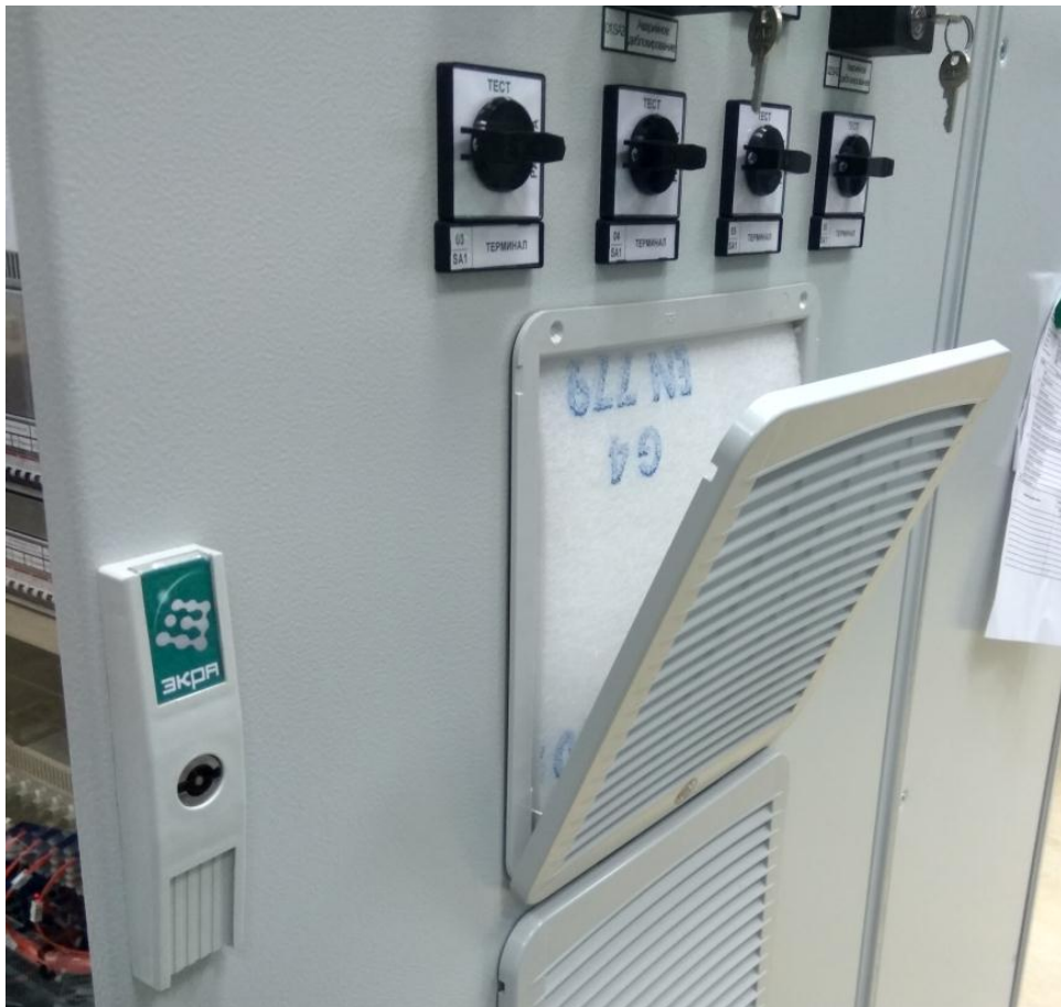
Рисунок 33 – Внешний вид вентиляционной решетки
